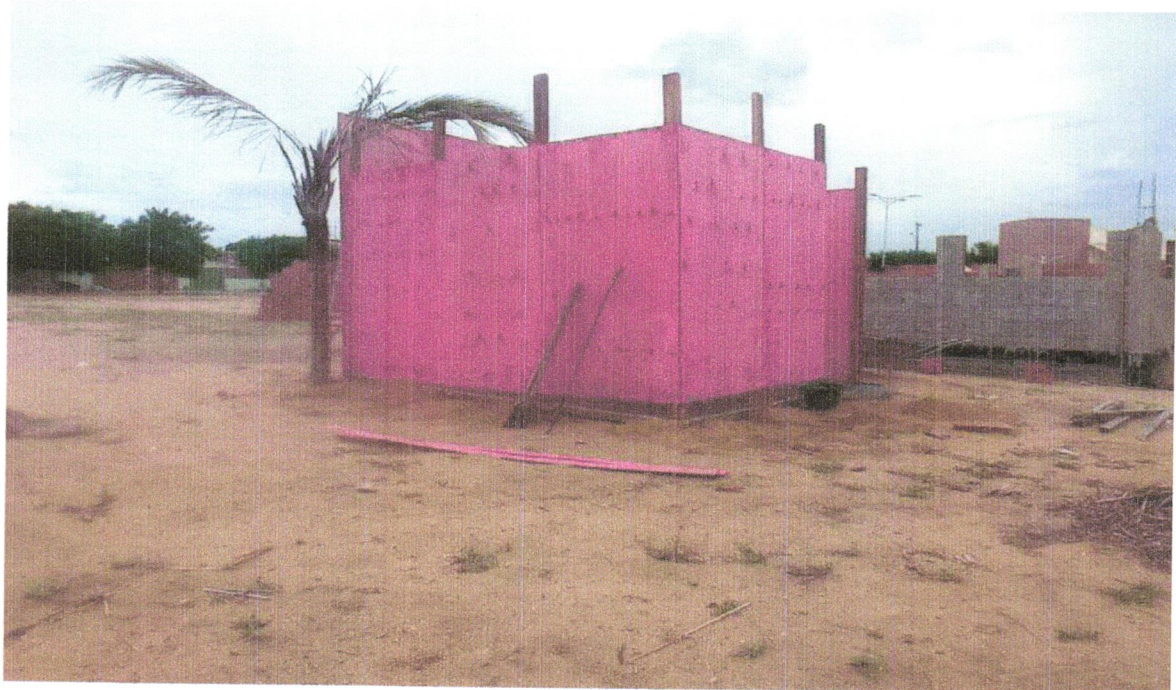
FOTO 10 - Barracão para Obras de Médio Porte Reaproveitamento
