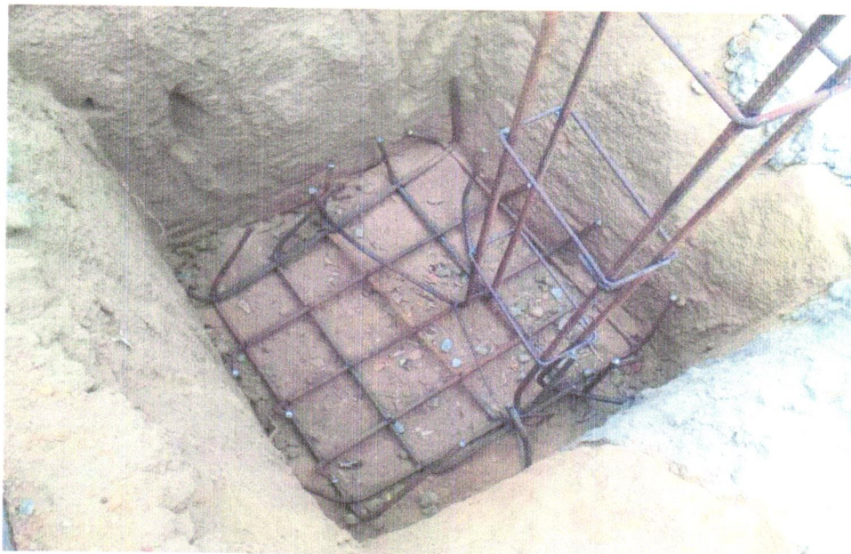
FOTO 02 - - ESCAVAÇÃO MANUAL PARA SAPATA AF_06/2017
